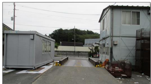
仮設事務所と旧事務棟
