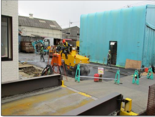
ペットボトル選別棟前 アスファルト工事
