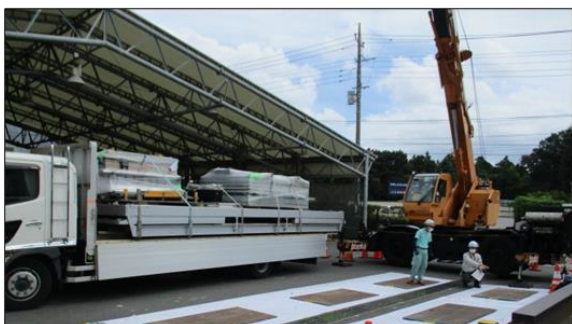
仮設事務所 設置工事
