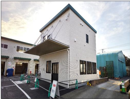
新事務棟 完成 市民受付スペースに庇を設置して雨風に対応
